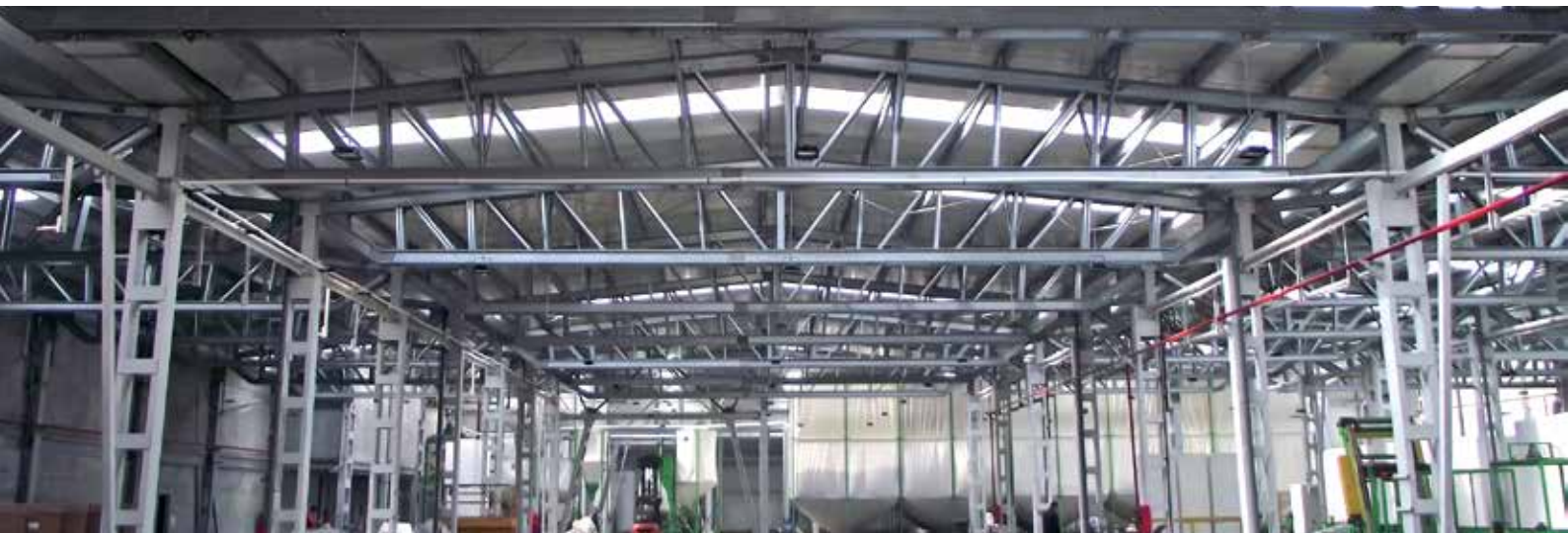
Hală depozit Rm. Vâlcea - 3150 mp
