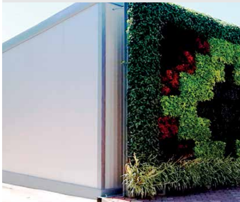
Anexă utilități | Annex | Grădina Botanică Jibou
